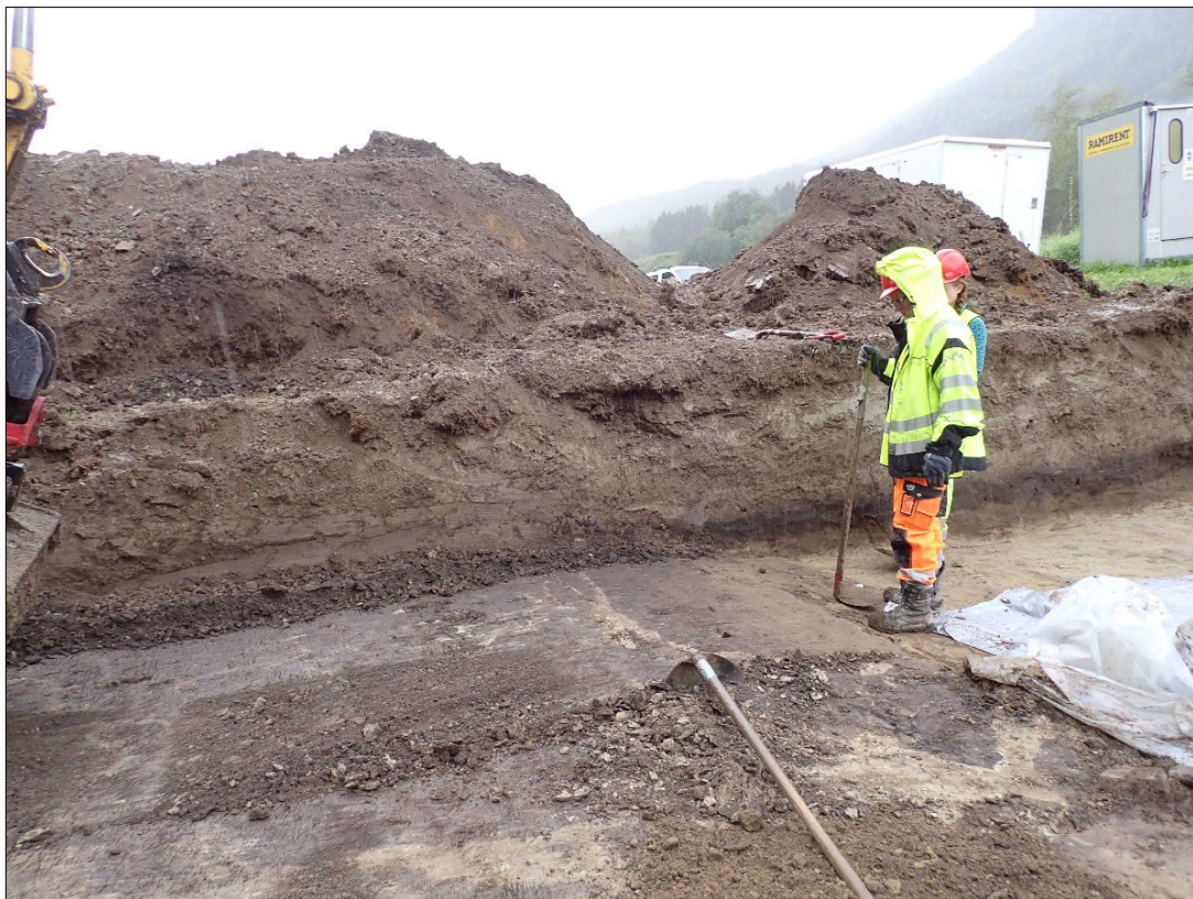
Figur 15. Flateavdekking på lokalitet 3, ser de generelt dype jordavsetningene som måtte fjernes med gravemaskin før vi kom ned på undergrunn. Sett mot sørvest.
